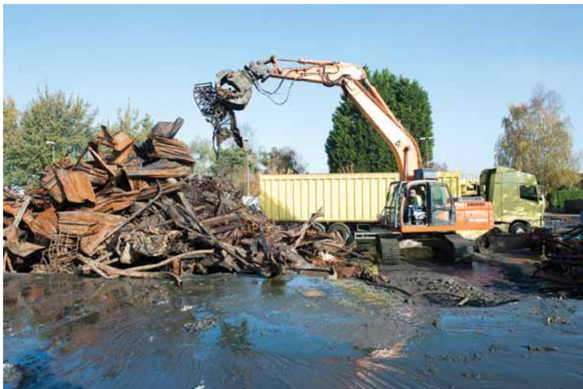
Si les délais sont tenus, les salariés de l'entreprise Copak pourraient retrouver une usine toute neuve dès juillet 2015.
